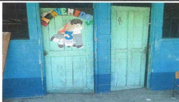
Foto 3: Cambios de puertas de la escuela, por que están hechas de maderas y se cambiarán por la de metal.
